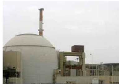
تصویر ۳. نیروگاه ۱۰۰۰ مگاواتی شکافت هسته‌ای بوشهر راکتور این نیروگاه، زیر قسمت گنبدی شکل قرار دارد.
